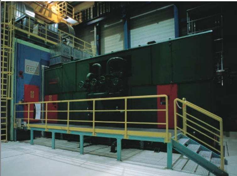
Gangway für ein Chemiegebäude
