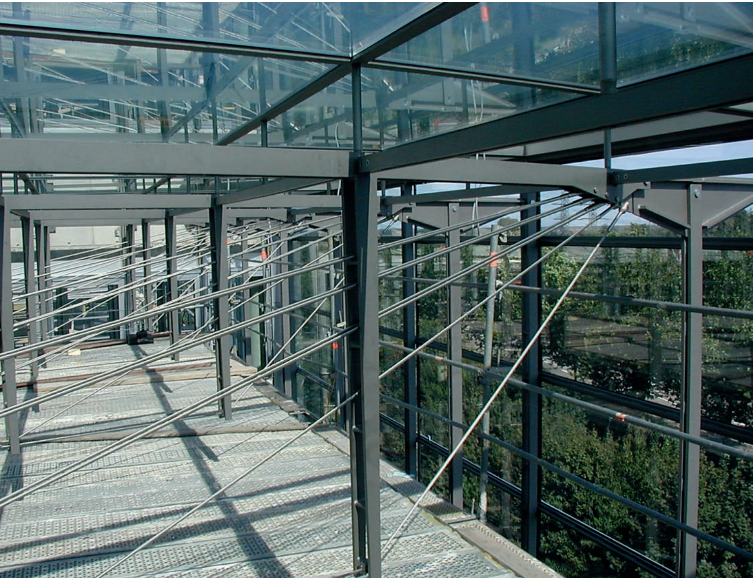
Tragkonstruktion SEW-EURODRIVE Bruchsal
