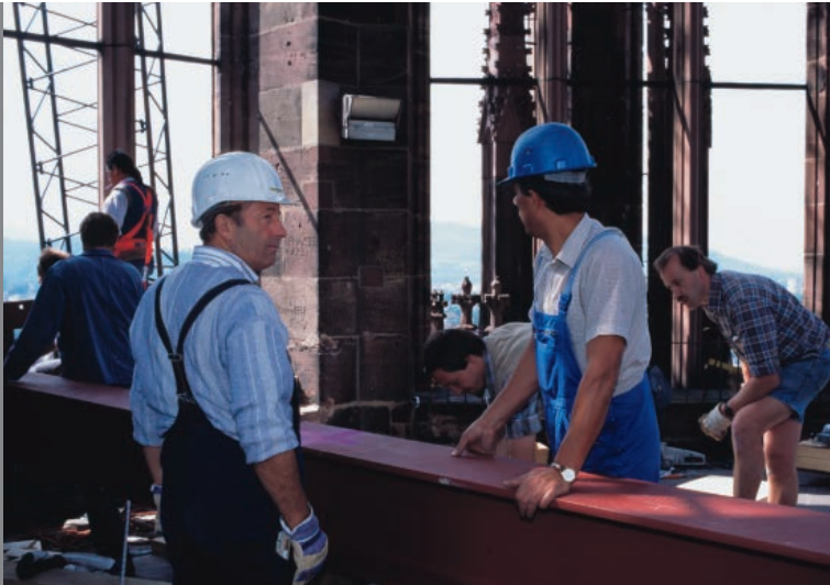
Sicherungskonstruktion am Freiburger Münster
