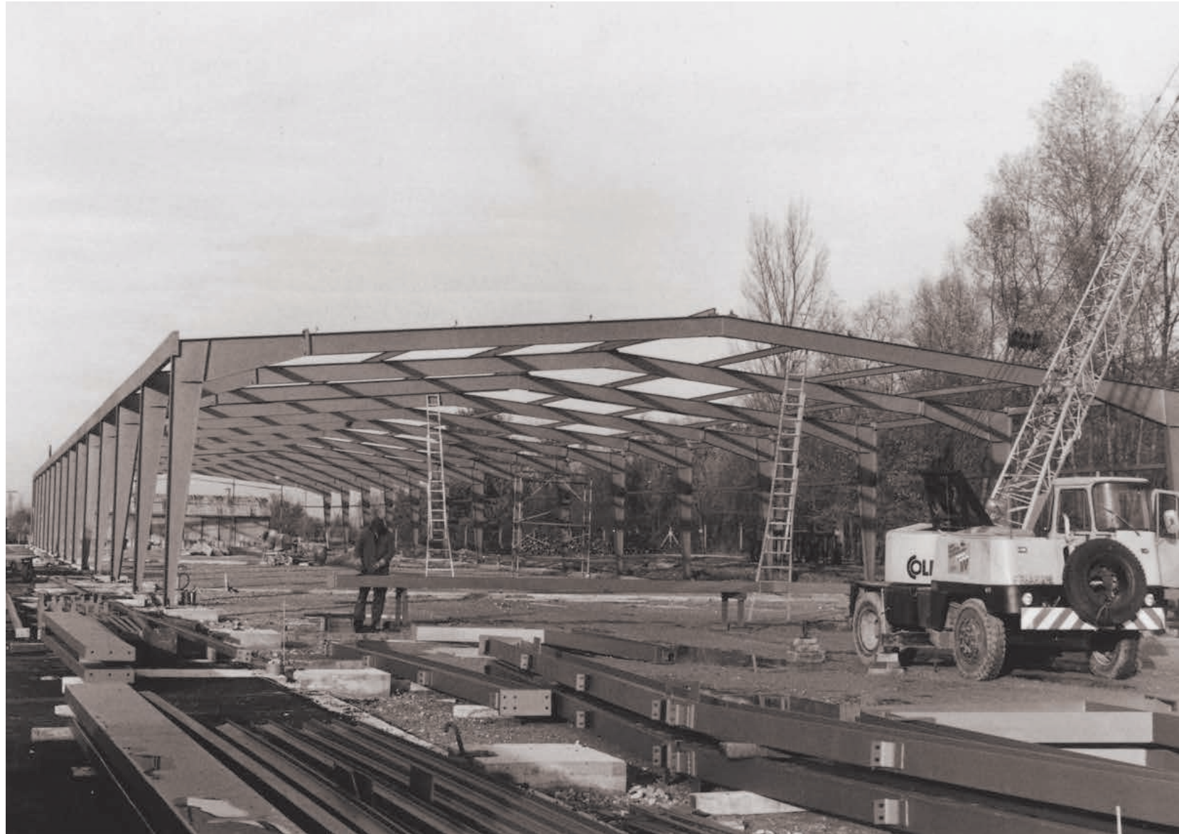
Hallenbau für die französischen Streitkräfte in Kehl
