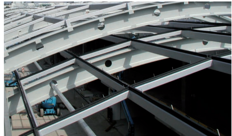
Cabrio-Dächer im NordWestZentrum in Frankfurt
