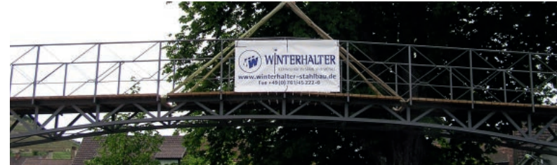
Fußgängersteg in Staufeu
