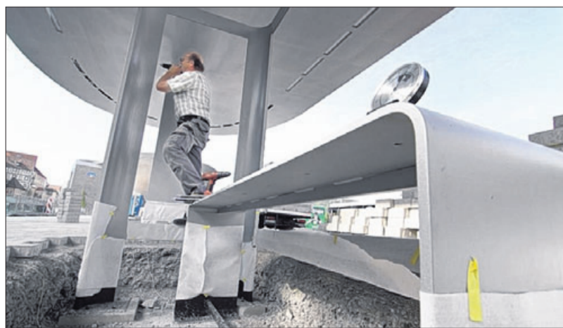
Bernd Fuchs schraubt Halterungen für die Glasscheiben in die neuen Wartehäuschen am Busbahnhof. „Wir sind auf der Zielgeraden“, sagt der Obermonteur der Firma Winterhalter. Foto: Weigert
