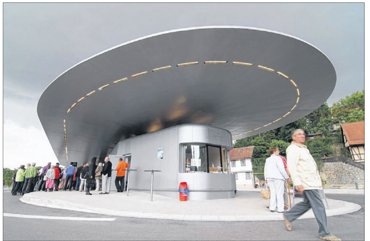
Sieht der neue Busbahnhof aus wie ein Ufo, das Raumschiff Enterprise oder ein Flugzeugflügel? Architekt Jürgen Marquardt freut sich über Vergleiche: „Ungewöhnliche Bauformen fördern eben die Phantasie des Betrachters.“ Fotos: Weigert
