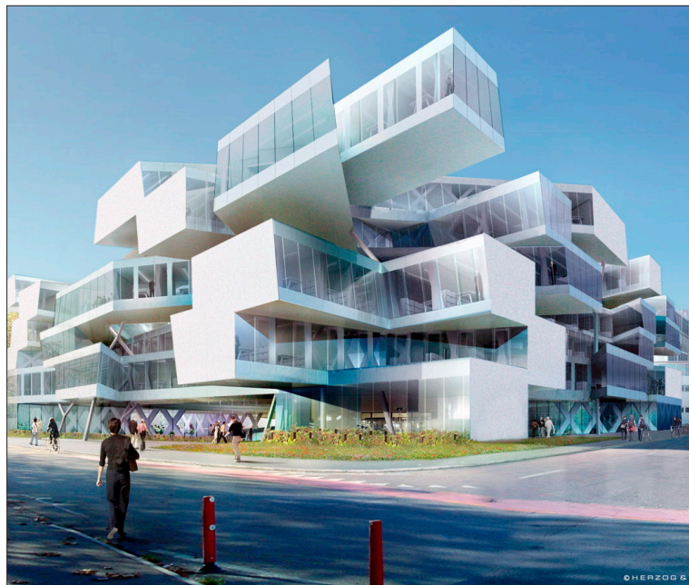
Die Leichtigkeit erhält der Neubau der Schweizer Actelion Pharmaceuticals Ltd dank der Stahlkonstruktion, die von der Winterhalter GmbH gefertigt wurde.
