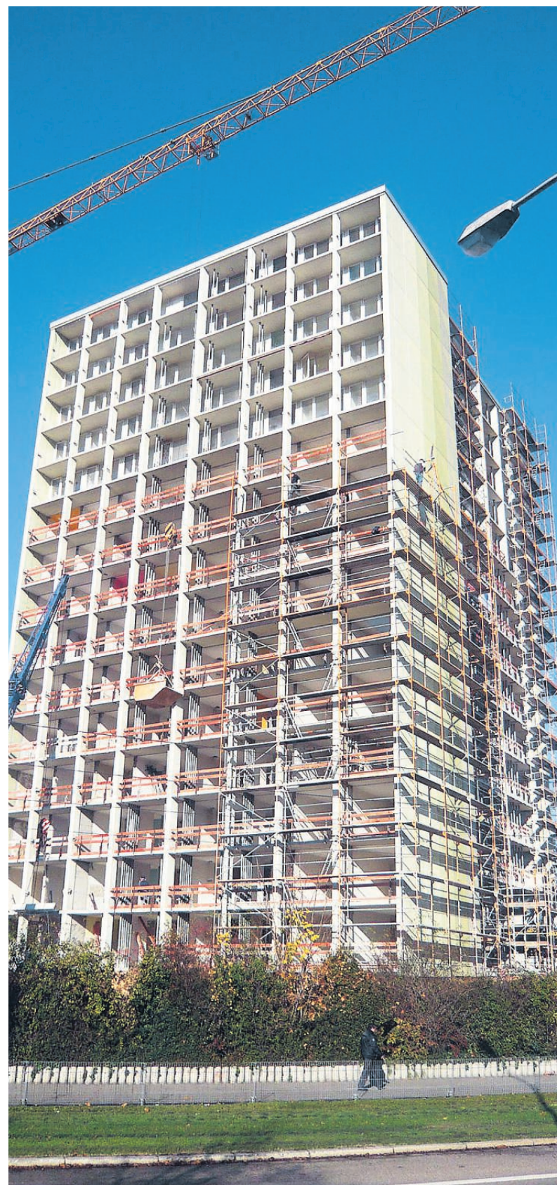
Die Sanierung zum Passivhochhaus bringt nicht allein ökologische und ökonomische Vorteile, sondern auch Erkenntnisse für die Wissenschaft. FOTO: FREIBURGER STADTBAU
